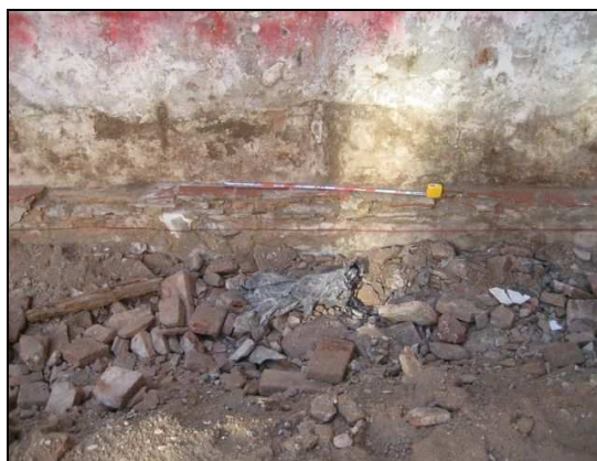
Vista de l'estructura UE 113, 115 i 116
