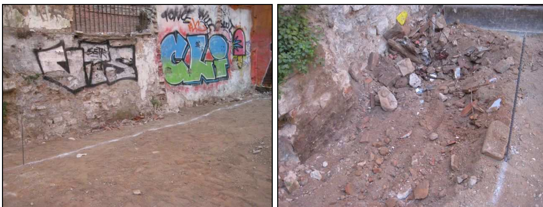
Retirat el paviment i la preparació actuals es marca sobre la UE 103 la rasa 100 intervenció.
