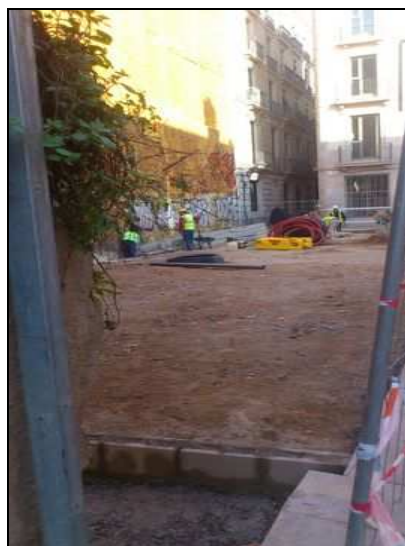
Vista nord de l'obra
