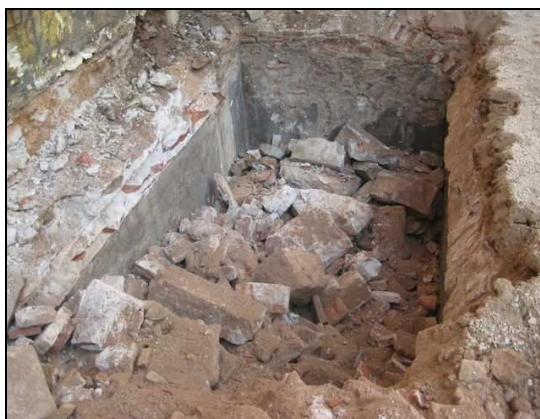
Interior de la UE 206
